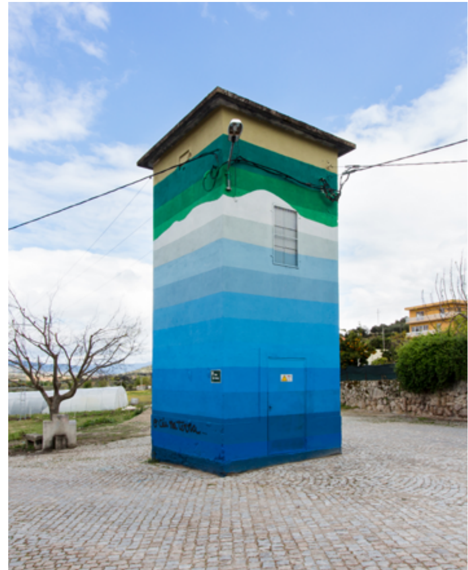
Invertido, MADEP/FBAUP Students, EDP Distribuição transformation substation, Junqueira, 2016.
