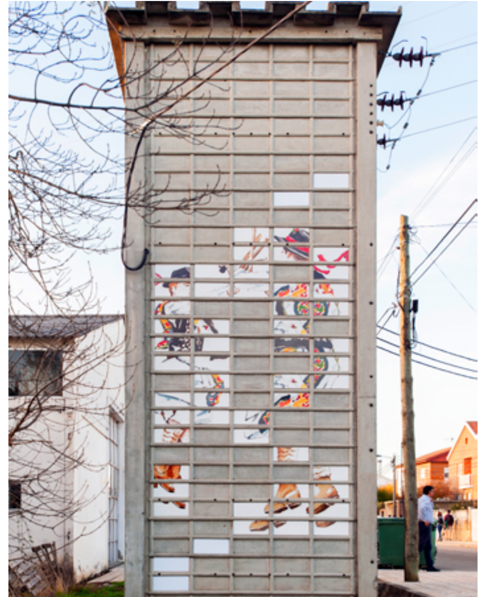
Pauliteiros , Miguel Schreck, EDP Distribuição transformation substation, Palaçoulo, 2016.
