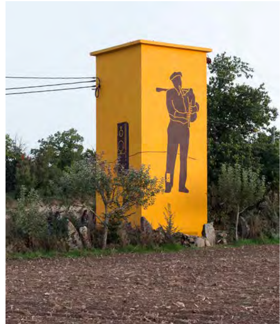
L Gueiteiro Eilectrico , Pedro Almeida, EDP Distribuição transformation substation, Duas Igrejas, 2016.
