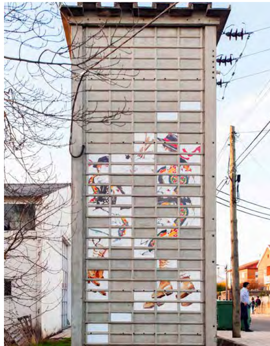
Pauliteiros , Miguel Schreck, EDP Distribuição transformation substation, Palaçoulo, 2016.
